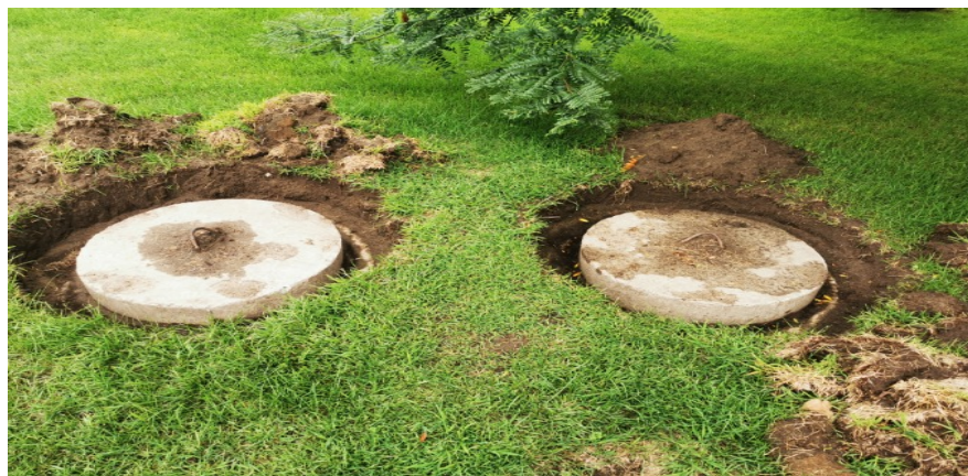
Façon de dégager les couvercles de la fosse septique.
